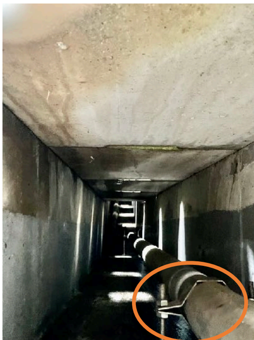
鳥取地区放射線施設の屋外排水管 防水コンクリートで作られた溝の中を配管が通っている。 振れ止め金具の間隔が、耐震性の基準となる
