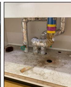
4階RI施設流し台とその下の排水管
