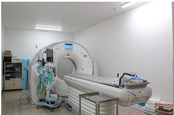
写真7 放射線治療室と同じフロアにある診断用CT CTガントリ手前に麻酔装置があり、室内に常設されている
