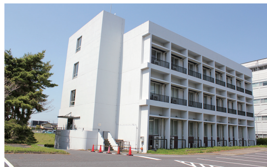
写真1 いばらき中性子医療研究センターの全景 患者は反対側の駐車場から治療室に入る
