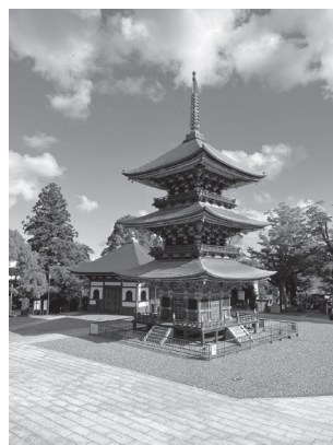
写真3 成田山新勝寺三重塔
