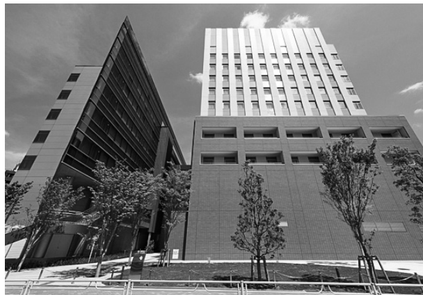
写真1 帝京大学医学部附属溝口病院の外観
