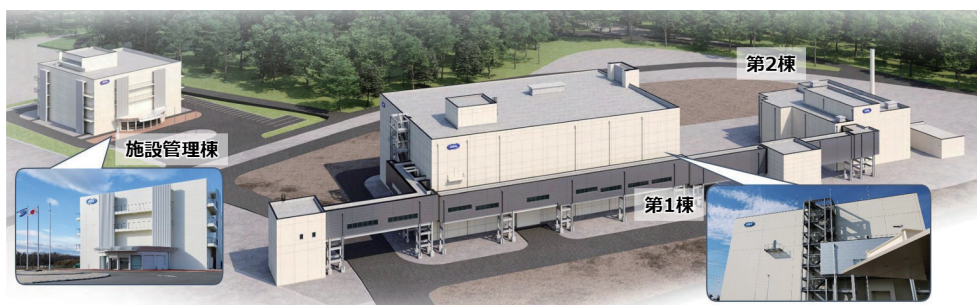
図1 大熊分析・研究センター 放射性物質分析・研究施設完成イメージ
