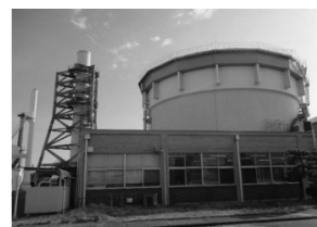
写真2 日本原子力研究開発機構 JRR-3(2021年耐震補強工事竣工)
