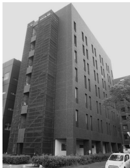
図1 アイソトープ研究センターの外観
