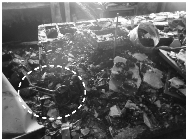
写真2 焼失した実験台上に残っていた出火元の投げ込み式ヒーター（点線内）
