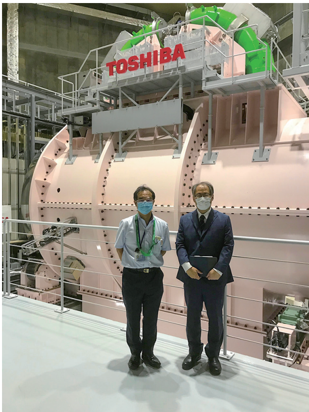
写真6 回転ガントリー本体外側
