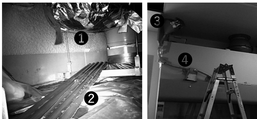
写真3 応急処置の事例：左写真は天井裏の状態，右写真は細胞培養室内：写真中の①は保温被覆材に作った水抜き穴，②は集水用の波板，③は集水用の漏斗，④は漏斗から流しへ排水流路としたホースであることを示す
