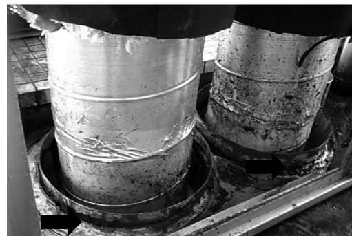
写真7 保温被覆材を取り除いた給気配管の高圧洗浄後の状態 写真内の➡は屋外側の浸水原因箇所を示す
