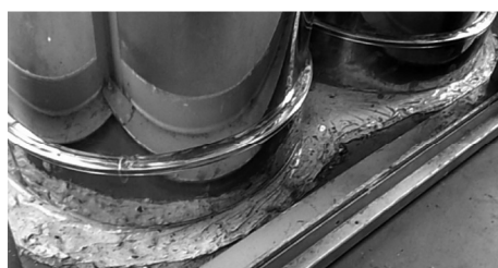
写真9 ステンレス製配管カバーを取り付けた給気配管と4Fのバルコニー床面の接合部付近の修理後の状態
