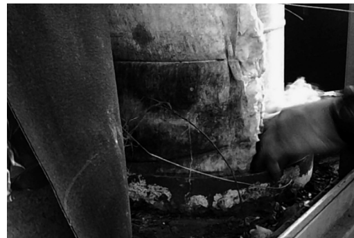
写真6 給気配管のステンレス製配管カバーを剥がした状態
