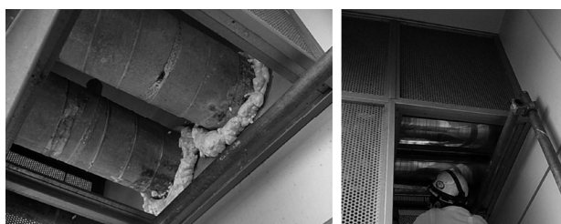
写真8 3Fバルコニーより撮影した壁面と給気配管の状態 左写真は壁面に発泡ウレタンを充填した直後の状態を示す。また、右写真はステンレス製配管カバーを取り付ける作業中の状況を示す
