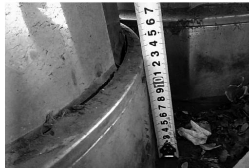
写真5 ステンレス製配管カバーで覆われた給気配管とバルコニー床面との接合部付近の修理前の状態
