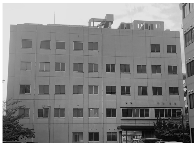
図 1 鹿田施設建物前景
