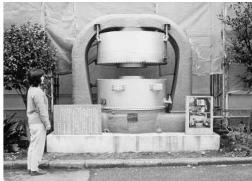
写真 第二次世界大戦後、日本で最初に作られたサイクロトロンのマグネット部分
