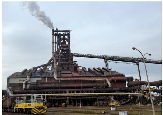
写真3 第4高炉の外景(右側に伸びているのがコークスを投入するコンベア、左手前がトービードカーを牽引する貨車、高炉下部で溶けた鉄がトービードカーに装填されている)
