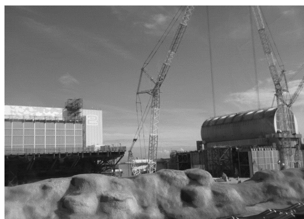
写真19 前室が設けられた2号機（左）とドーム型天井が設けられた3号機（東京電力撮影）
