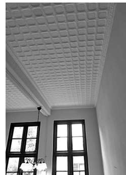
駒込本館天井
