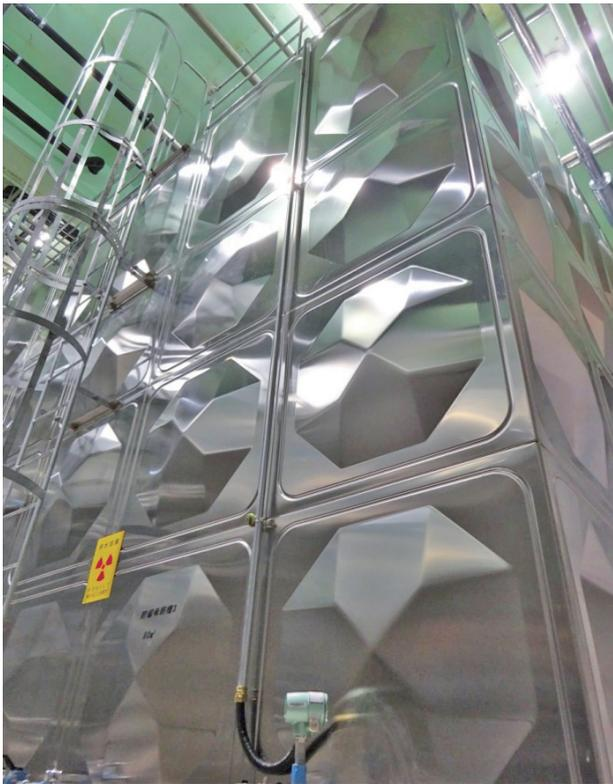
写真6 地下に設置されている貯留槽兼希釈槽
