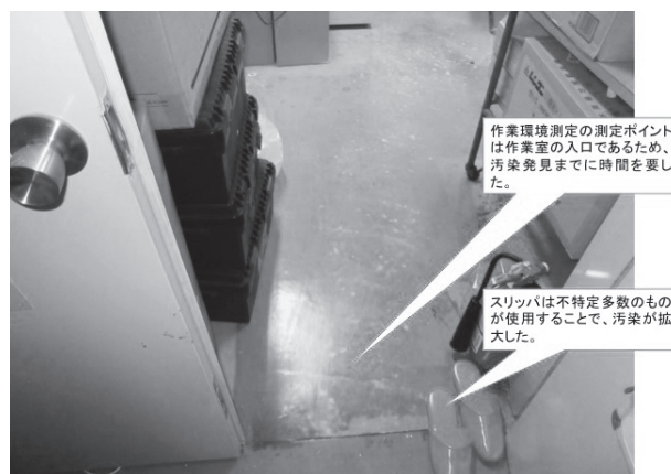
図4 原因となった作業室(測定ポイント周辺)
