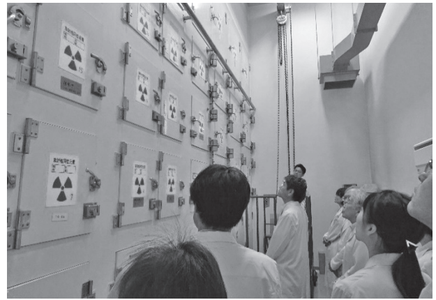
写真2 放射性物質の貯蔵室
