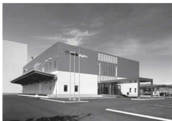
写真 日本メジフィジックス(株)札幌ラボの外観 札幌 IC より車で約 2 分
