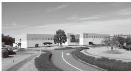
写真1 日本メジフィジックス(株)兵庫工場 全景 北摂三田テクノパーク（工業専用地域）に立地し、舞鶴若狭道・三田西ICより車で約5分
