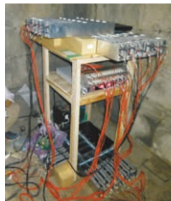
写真3 中央内室に設置した観測機器
