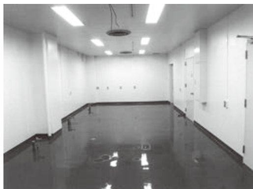
写真2 小屋のRC壁撤去で広い実験室を確保
