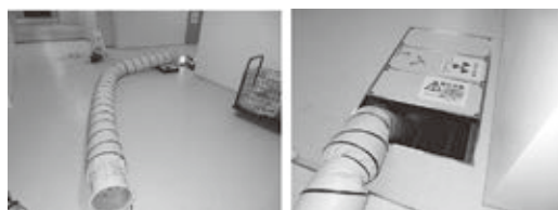
写真 2 ポータブルファンダクトによる強制換気措置
