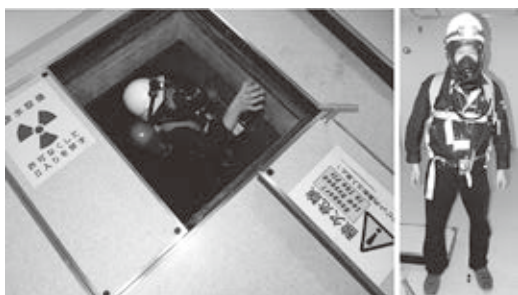
写真4 ピット内への進入（左）、空気呼吸器を装着した点検者（右）
