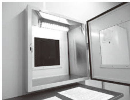
図4 管理区域と使用区域の間に設置されたパスボックス
