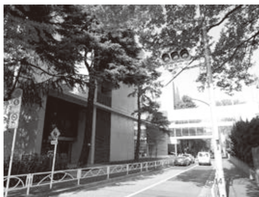
写真 1 放射線取扱施設（手前の建物が病院関係、奥の建物が医学部関係）
