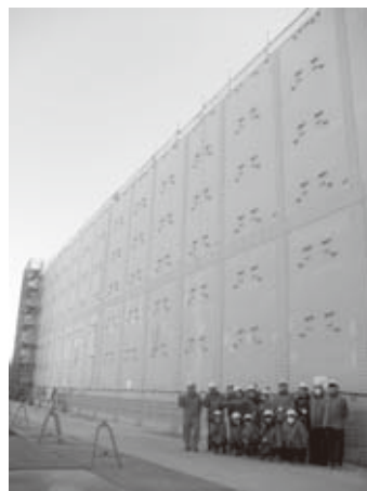
図3 津波対策工事現場見学の様子
