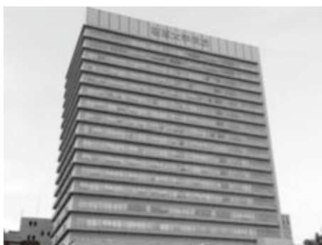
写真1 附属病院中央棟（病棟）
