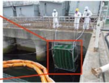
セシウムの除去性能の試験（設置作業）
