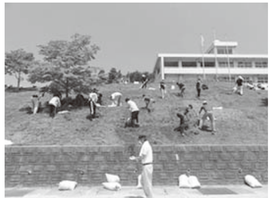
図 2 土手の表土剥離作業
