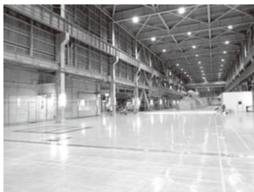
写真 1 タービン室内部
