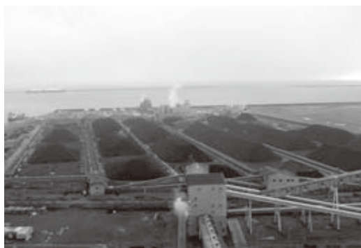
写真2 苫東コールセンター
