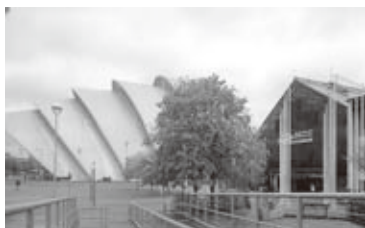
写真1 スコットランド エキシビション&コンファレンスセンター
