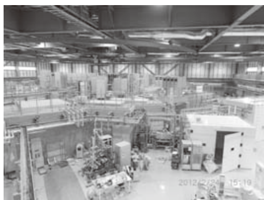
写真 2 工事中のビームライン
