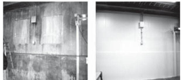
施工前 施工 5 年
