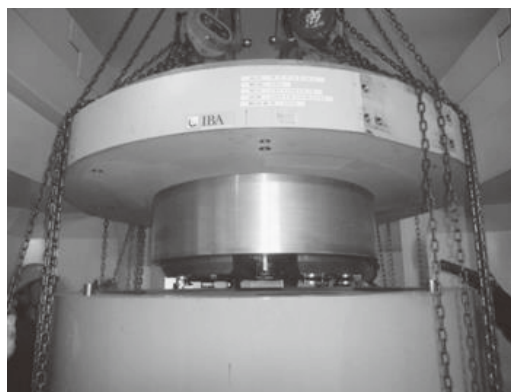
図6. サイクロトロン本体解体作業
