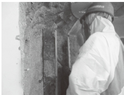
図8. 自己遮蔽体のはつり作業
