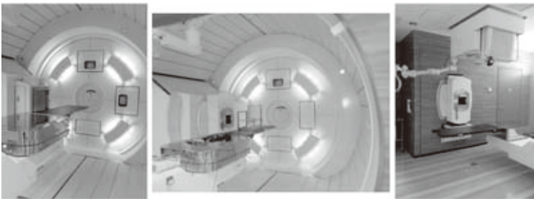
写真4 スポットスキヤニング照射法を採用した回転ガントリー照射治療室（左）、2重散乱体照射法を採用した回転ガントリー照射治療室（中）及び水平固定照射室（右）
